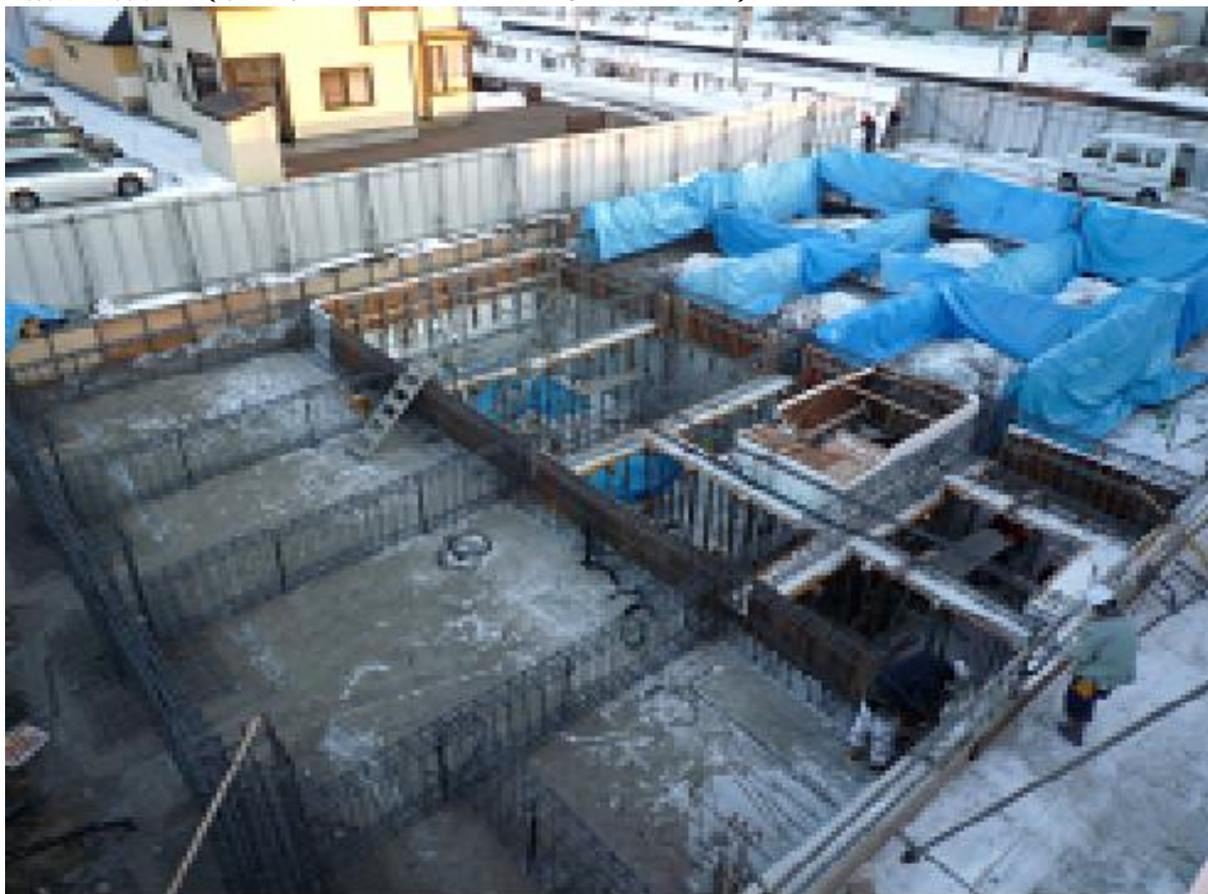
ダイケア棟基礎・柱鉄筋組立
