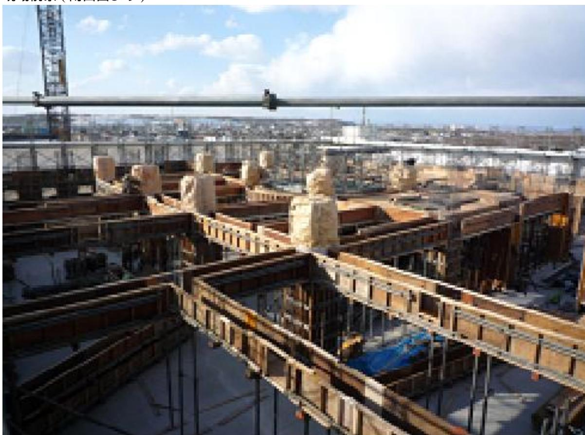
4階床梁型枠架設・スラブ型枠組立
