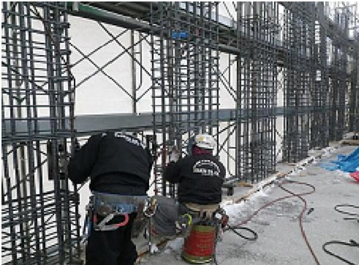
病院棟 4階柱鉄筋エンクローズ溶接 寒い中 お疲れ様です
