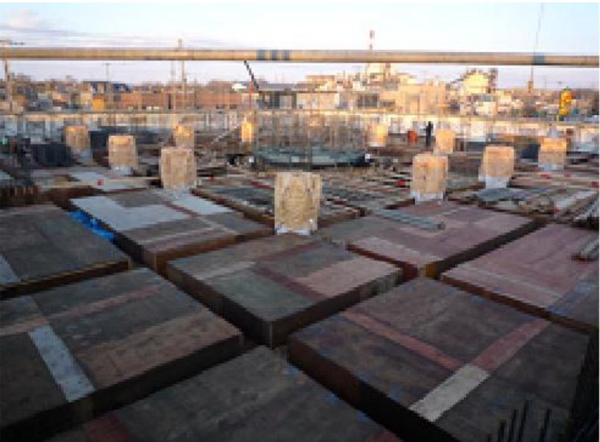
2階床型枠施工（柱の中に雪がはいるようにしてます）
