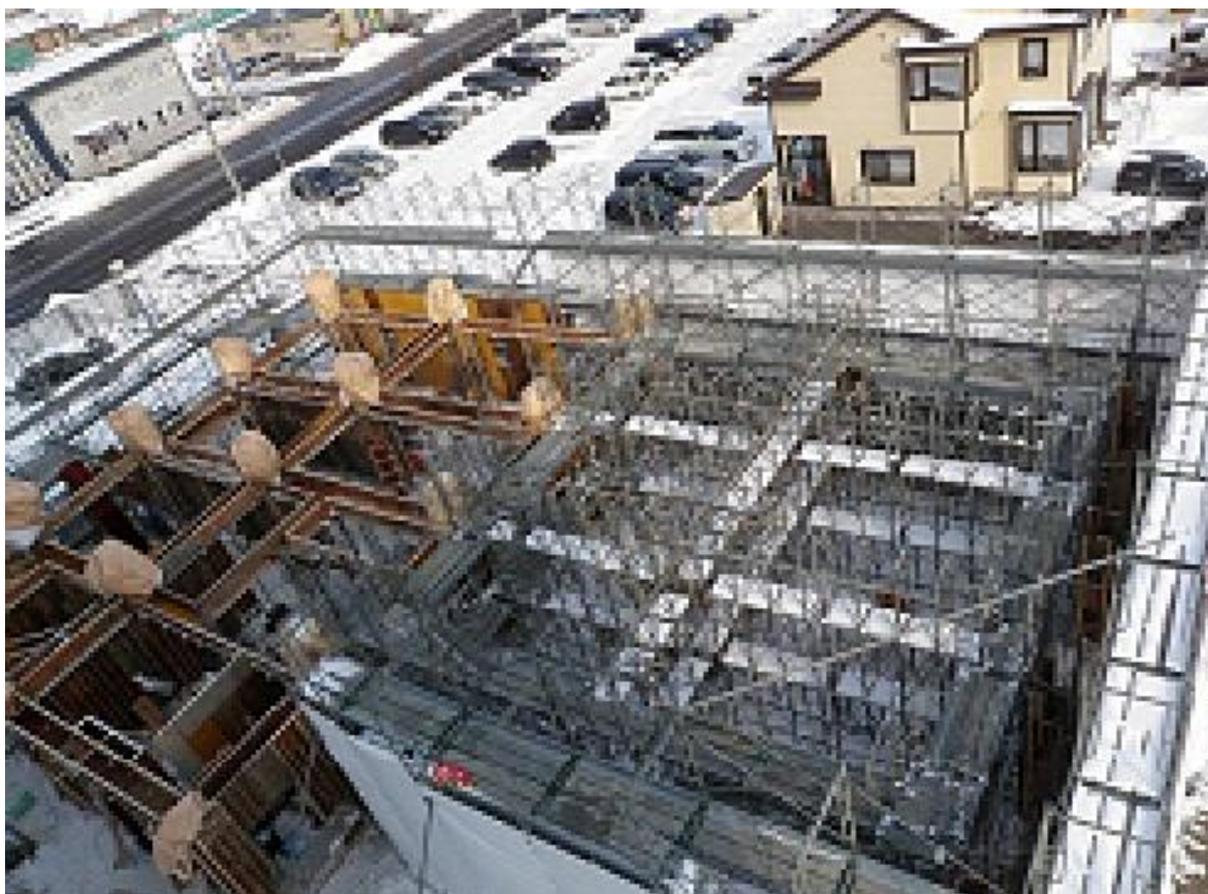
ディケア棟 2階床梁型枠架設
