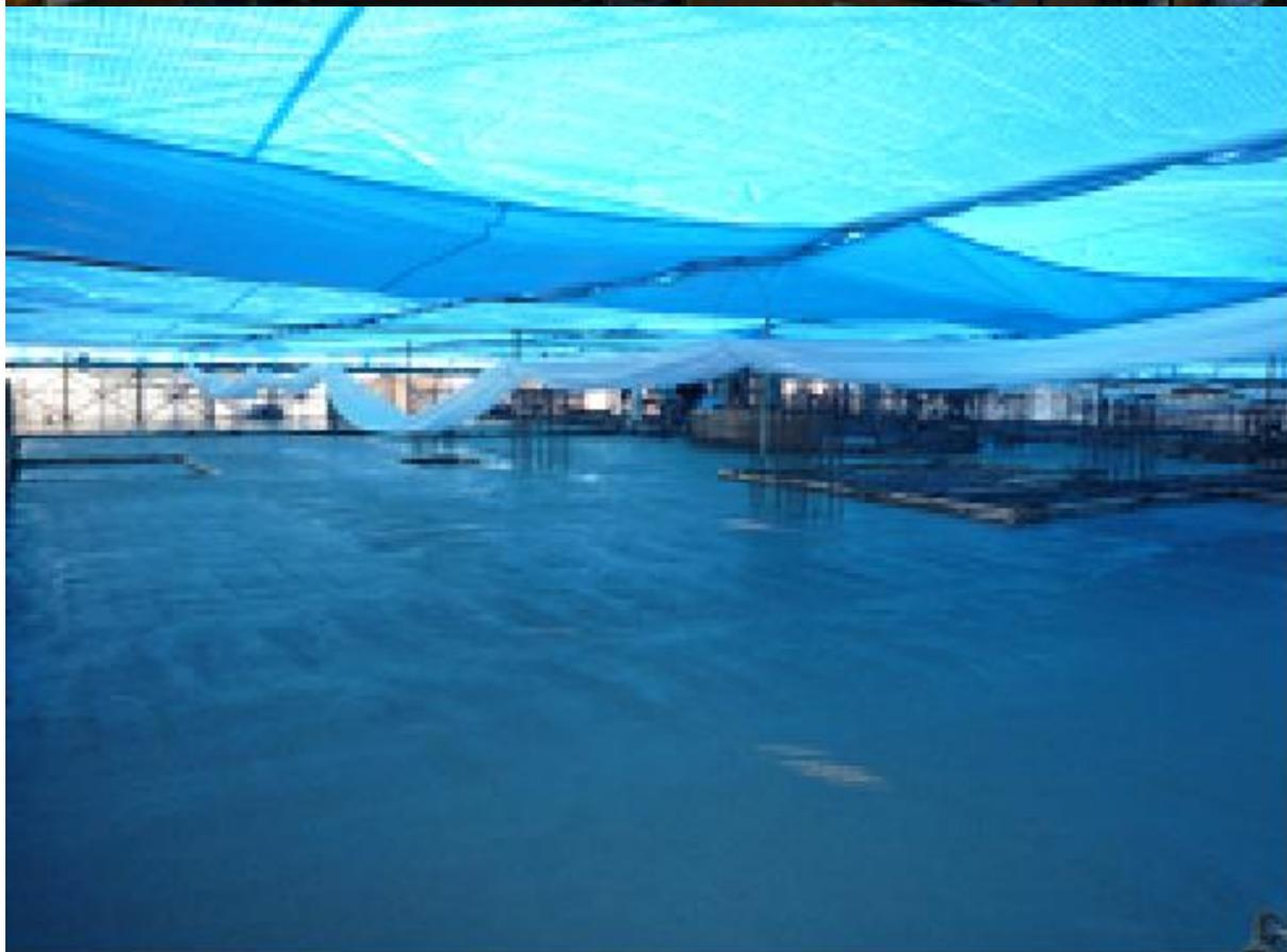
1階立上り・2階床コンクリート打設
