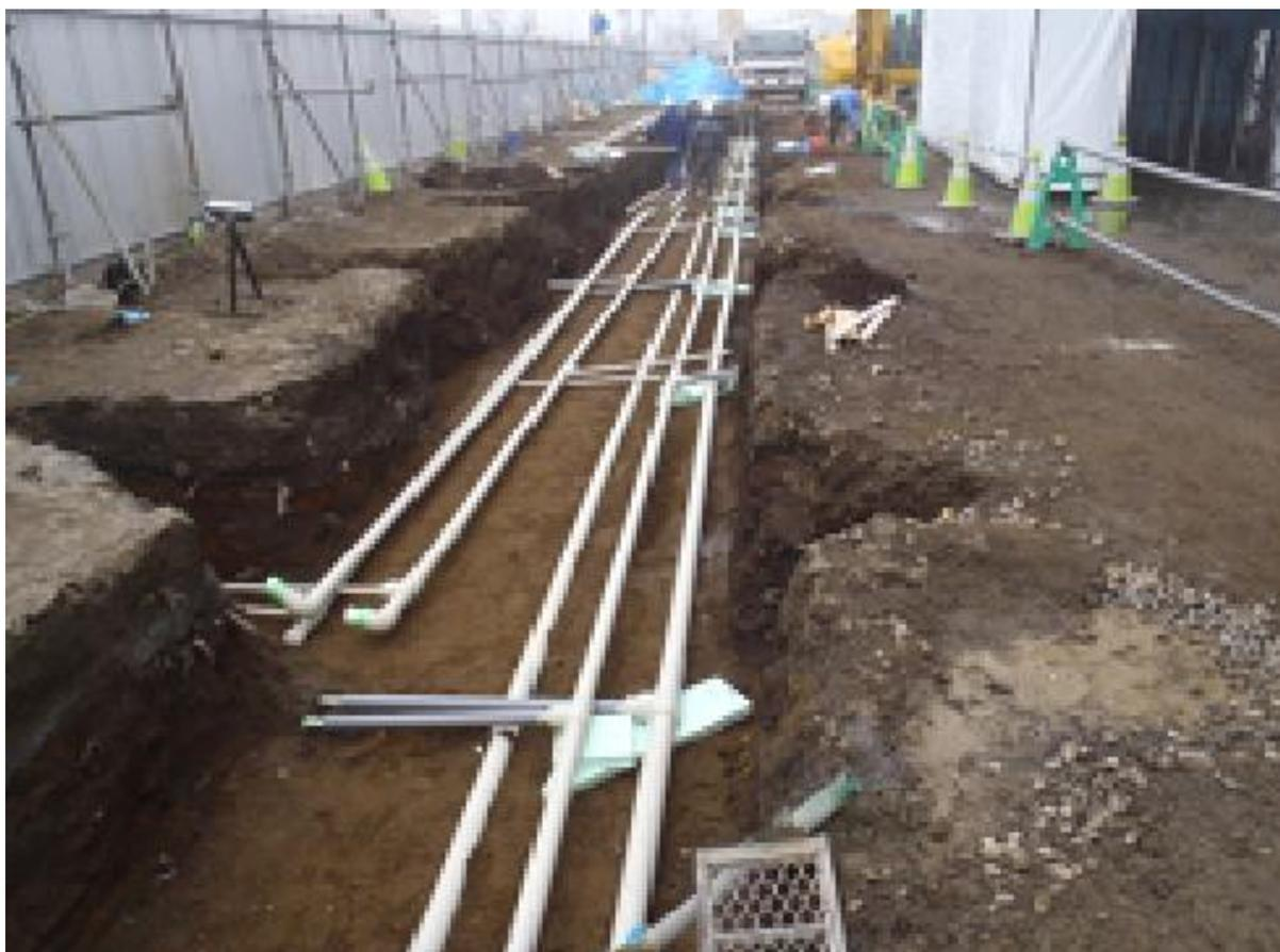
外部：地中熱ヒートポンプ配管接続工事
