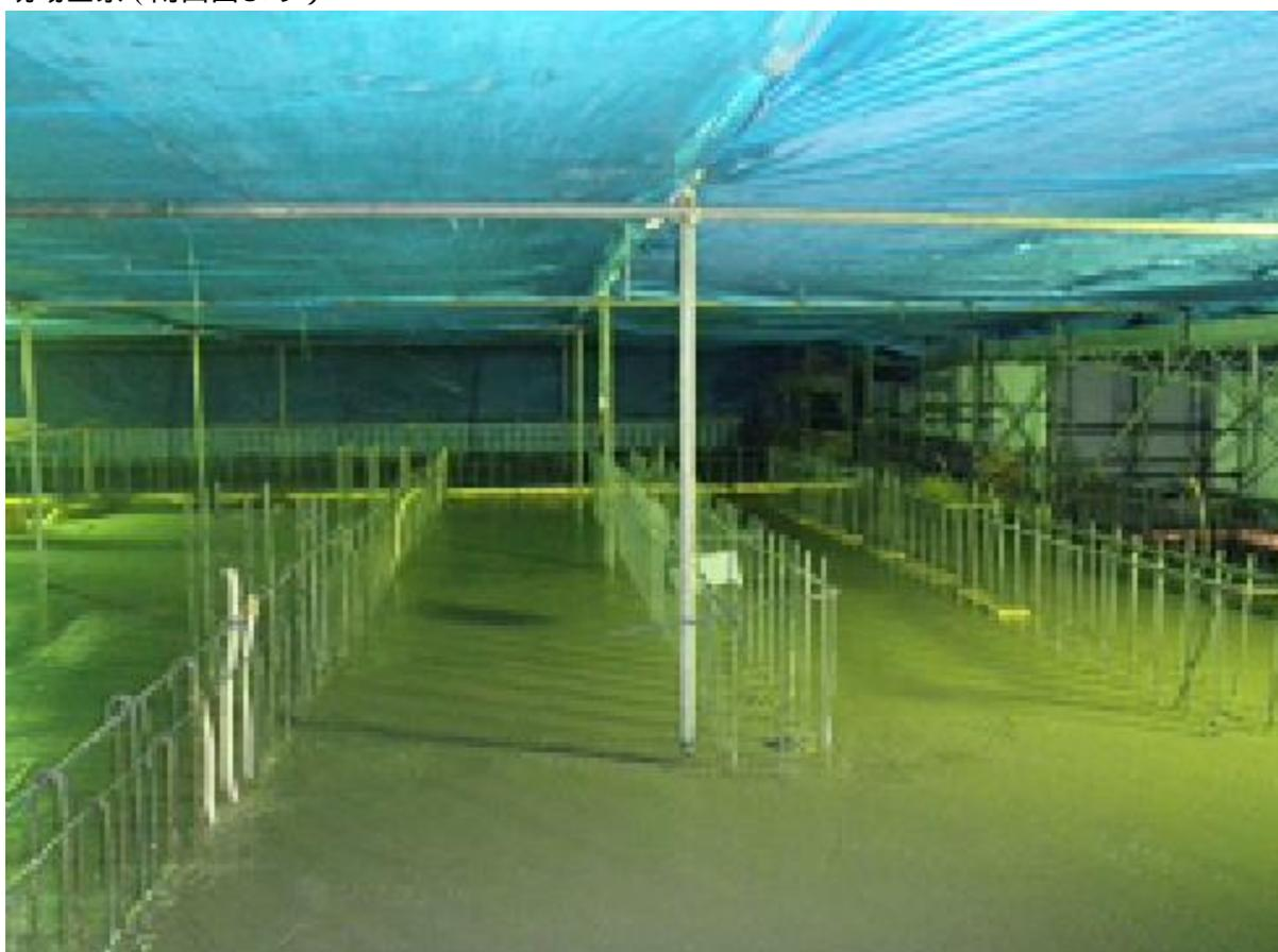
デイケア棟：1階立上りコンクリート打設
