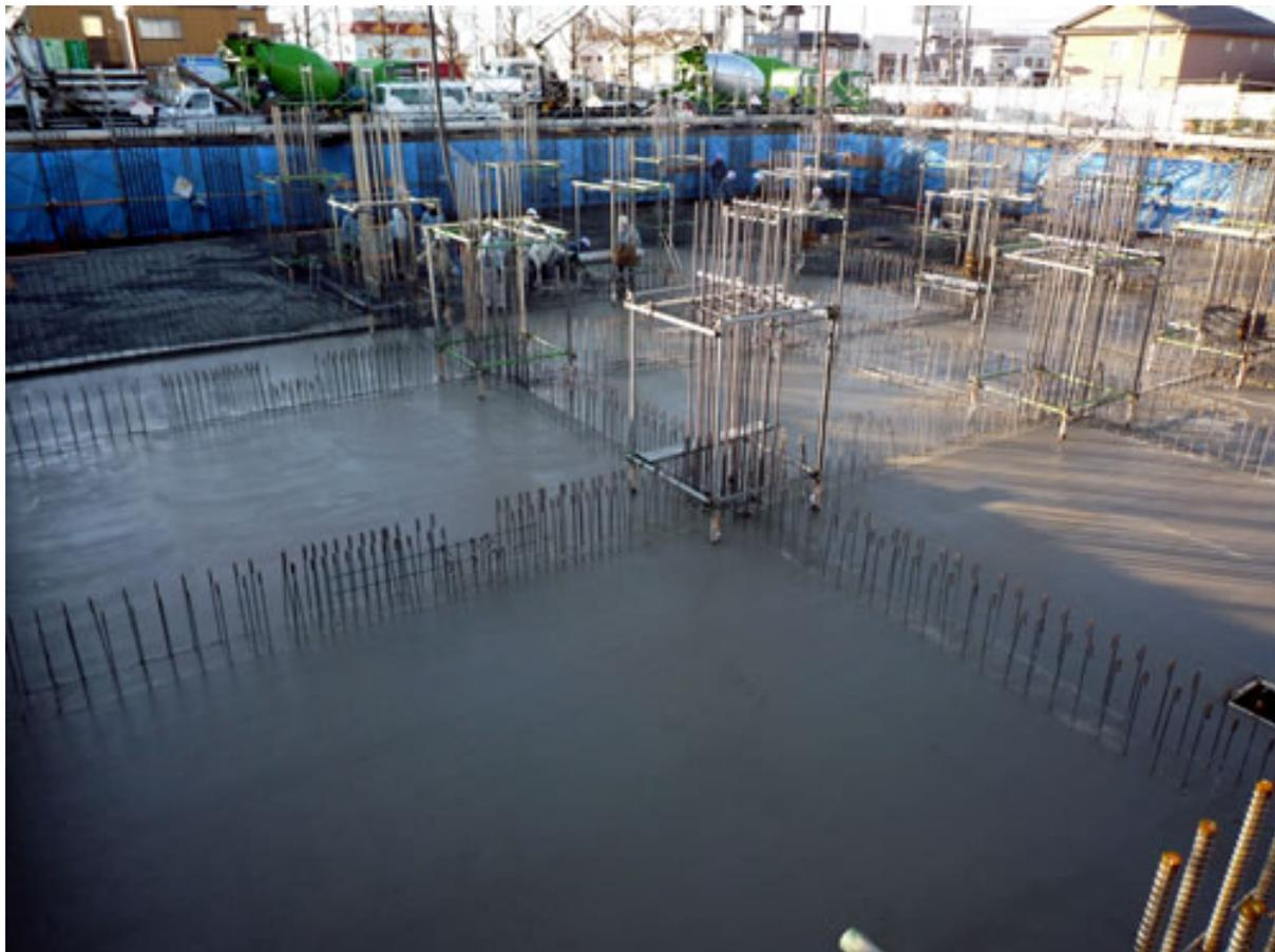
[ 病院棟耐圧盤コンクリート打設 ] スケートリンクの様でした
