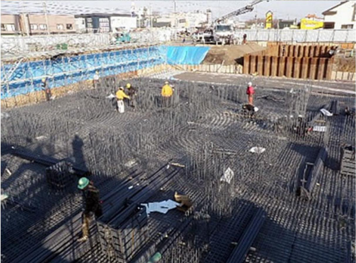
[ 病院棟耐圧盤・基礎 ] 梁下鉄筋組立
