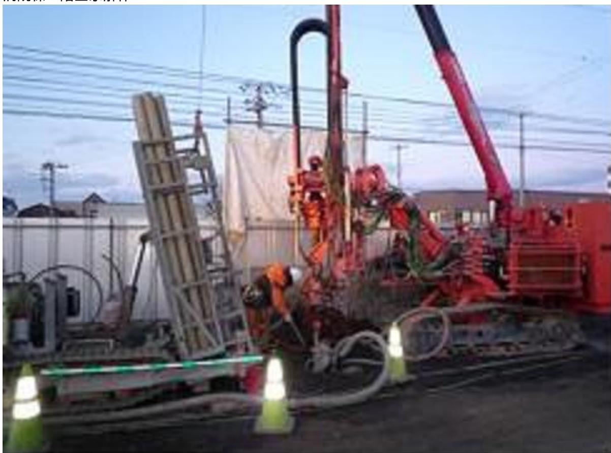
地中熱配管掘削工事（14本目、全部で40本行ないます）
