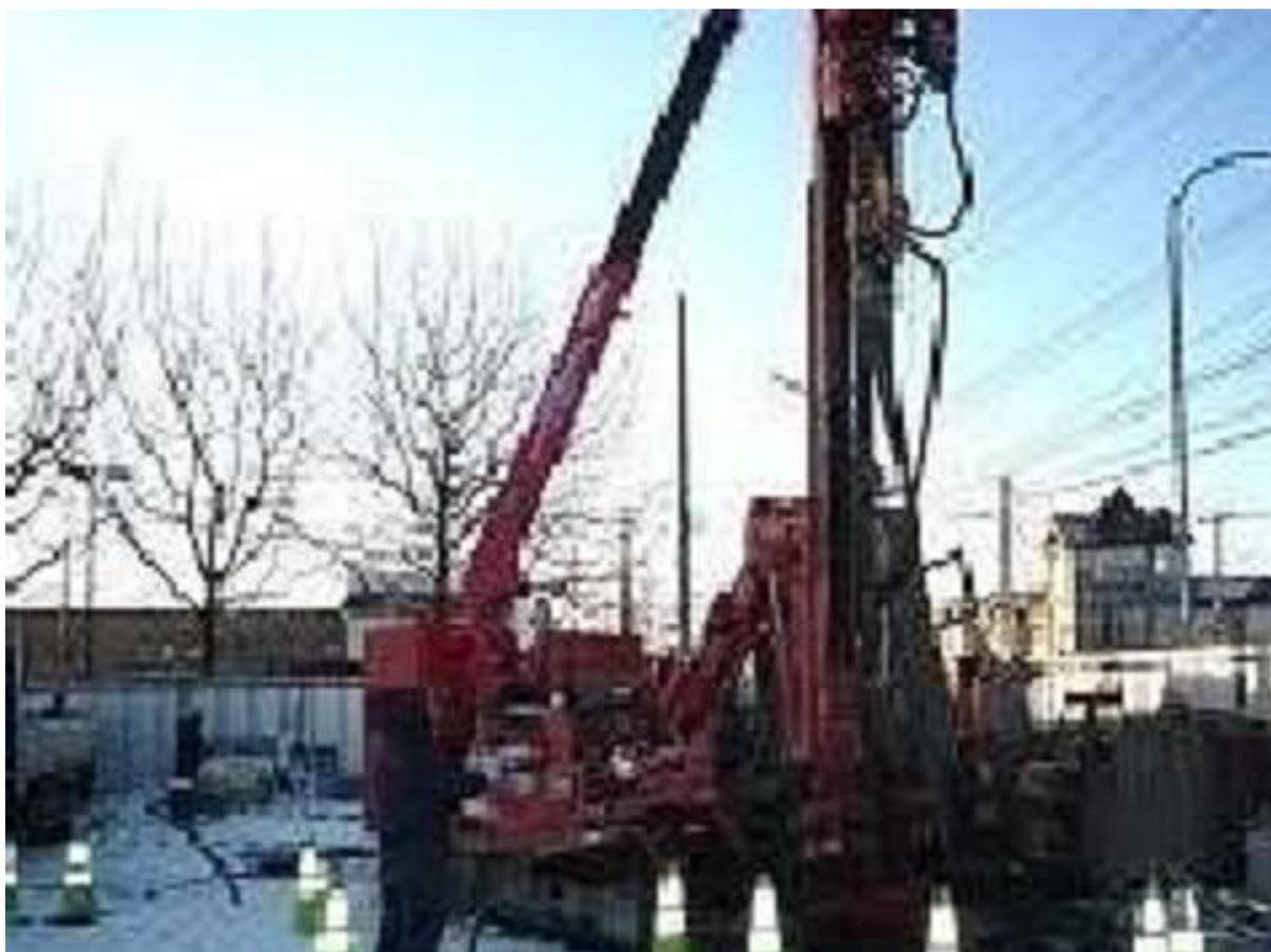
地中熱配管掘削工事（8本目、全部で40本行ないます）
